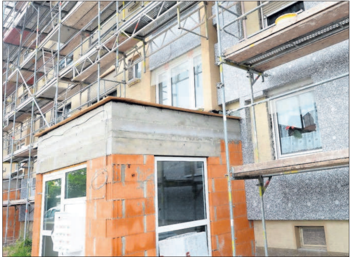
Aktuelles Projekt: Dämmarbeiten in der Spitalbachstraße, hier an der Ecke zur Adolf-Kolping-Straße. FOTO: LM
